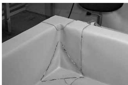
**Рисунок 2.8.** Полностью изолированный внутренний угол парапета.
