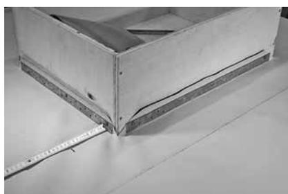
**Рисунок 1.4.** На горизонтальной поверхности кровли на расстоянии 100 мм от стены или парапета наносят риски.
