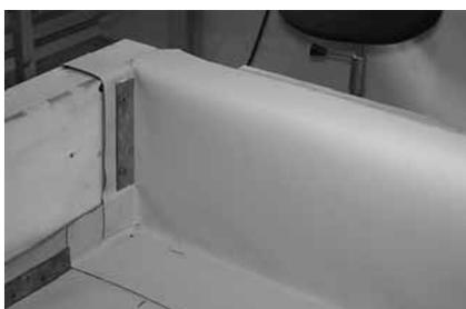
**Рисунок 2.3.** А затем по всей горизонтальной поверхности. Торец полосы мембраны механически закрепляют на парапете.
