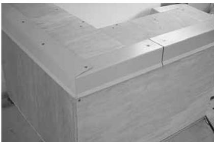
**Рисунок 5.1.** Для изоляции внешнего угла парапета со стороны фасада из ламинированной ПВХ-жести нарезают полосу необходимой ширины, формируют профиль нужной конфигурации (капельник), сгибают под прямым углом по длине профиля и механически закрепляют на внешнем угле парапета.
