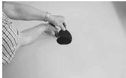
**Рисунок 6.2.** В кровельной мембране над водоприемной трубой вырезают отверстие немногим больше диаметра трубы.
