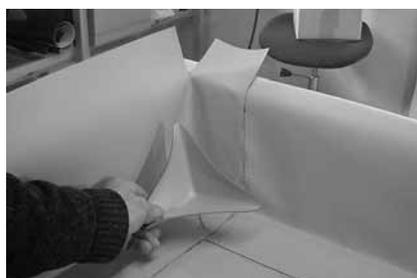
**Рисунок 2.6.** Для его надежной герметизации применяют готовые накладки из неармированной мембраны.
