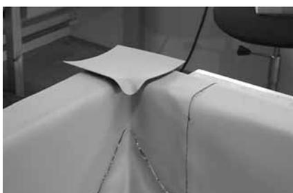
**Рисунок 2.7.** Завершают изоляцию угла парапета, устанавливая накладку на внутренний угол парапета со стороны кровли.
