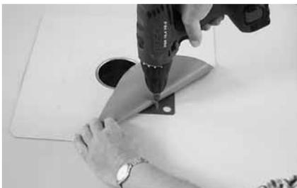
**Рисунок 6.3.** Водосливную воронку устанавливают на водоприемную трубу и механически закрепляют к основанию кровли (не менее чем в двух местах на одну воронку).
