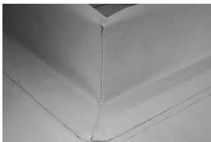
**Рисунок 1.10.** Полностью изолированный внешний угол вентиляционной шахты.
