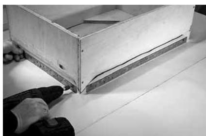
**Рисунок 1.3.** Механически закрепляют с помощью специальных шин.
