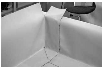
**Рисунок 2.5.** После завершения всех сварочных работ внутренний угол на горизонтальной поверхности кровли приобретает следующий вид.
