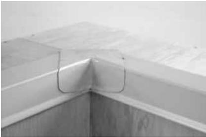
**Рисунок 5.5.** Для изоляции внутреннего угла парапета со стороны кровли из ламинированной ПВХ-жести нарезают полосу необходимой ширины, формируют профиль нужной конфигурации (капельник), сгибают под прямым углом и механически закрепляют на внутреннем угле парапета.
