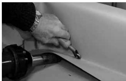
**Рисунок 2.2.** Полосу мембраны надежно закрепляют на парапете, спускают вниз с нахлестом в 100 мм на горизонтальную поверхность кровли, проваривают в месте перегиба мембраны.
