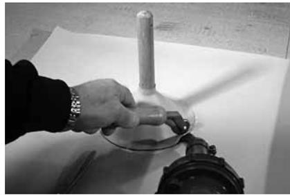
**Рисунок 4.6.** Нижнюю кромку конуса приваривают к кровельной мембране.
