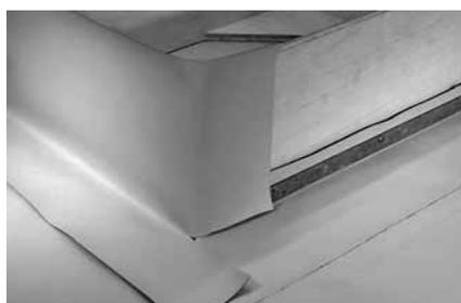
**Рисунок 1.7.** Затем проваривают вертикальные соединения мембран.
