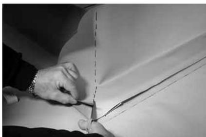
**Рисунок 1.9.** И, наконец, проваривают горизонтальные поверхности.
